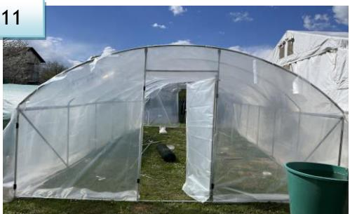
11. Pričvrstite foliju bijelim stezalkama. Treba biti 6 komada stezaljki na vrhu i 4 komada dole, bitno je da stavite komad trake gdje ćete dodati stezaljku da zaštitite foliju.
