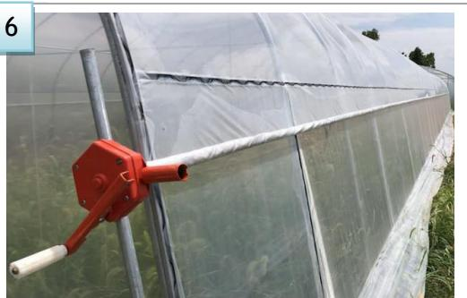
5. Montirajte roll up ventilaciju tako da namotate foliju na dnu plastenika oko cijevi i pričvrstite je stezalkama. Obavezno spojite cijevi vijcima prije nego što zamotate foliju.
