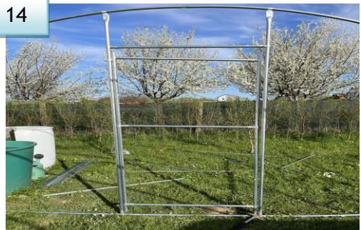
14. Vrata su montiraju kao na slici sa tri kratke cijevi u sredini i jedna krtaka cijev iznad vrata, sve cijevi se spajaju metalnim stezaljkama sa vijcima i indeksnim ključem
