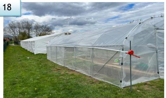
18. spojite cijevi za roll up ventilaciju vijcima i zamotajte foliju oko cijevi i pričvrstite stezaljkama
