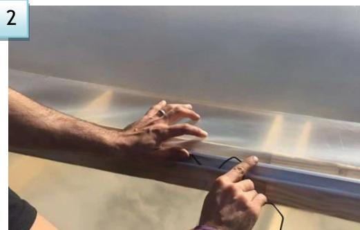
1. Postavljanje folije na plastenik povlačenjem s jedne strane na drugu ili na središte krova i spustiti folije da pada na strane. Budite oprezni kako se folija ne bi oštetila oštrim vijcima ili metalnim cijevima i profilima. Prije postavljanje folije uvijek stavite malo pjenaste trake na oštре predmete.
