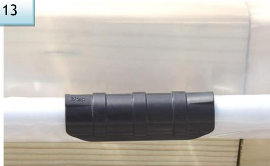
13. Uz vrata treba koristiti crne stezaljke za pričvršćivanje folije i sa strane za motanje ventilacije, staviti malo prozirne trake prije postavljanje stezaljki za zaštitu folije
