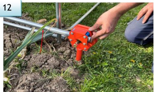
12. Dodatni kratki komad cijevi treba spojiti kao na slici između duge cijevi i ručke za motanje ventilacije.
