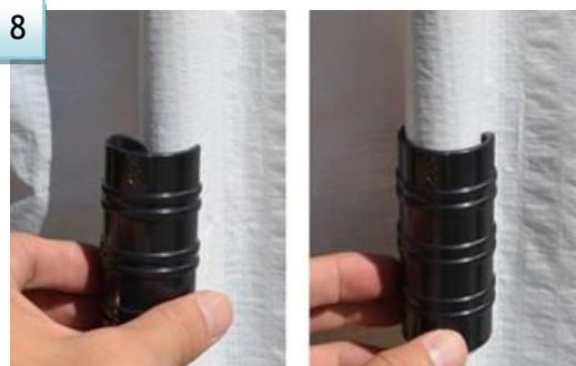
7. Pričvrstite foliju stezalkama, rukom držite krovnu i bočne folije i zategnите prije postavljanje stezaljki. Zalijepite komad prozirne trake na mjestu za stezaljke da ne bi oštetile foliju ako kasnije trebate dodatno zategniti foliju.
